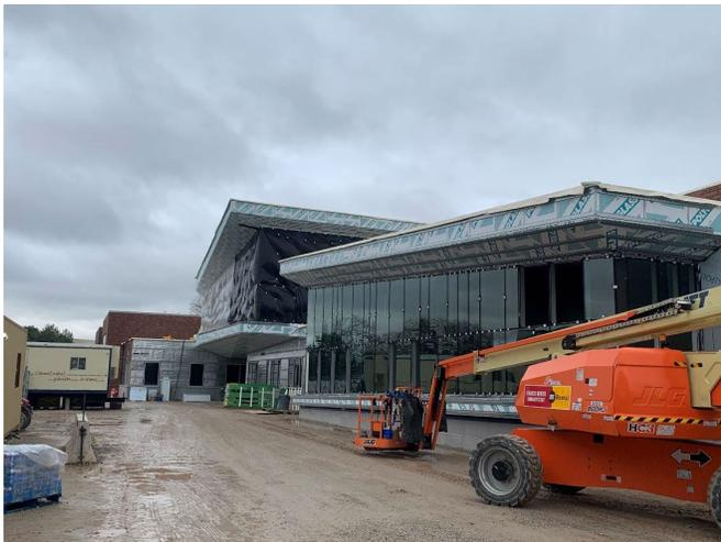
Continuamos con la instalación de los muros de cristal y el revestimiento metálico en el área sur del edificio.
