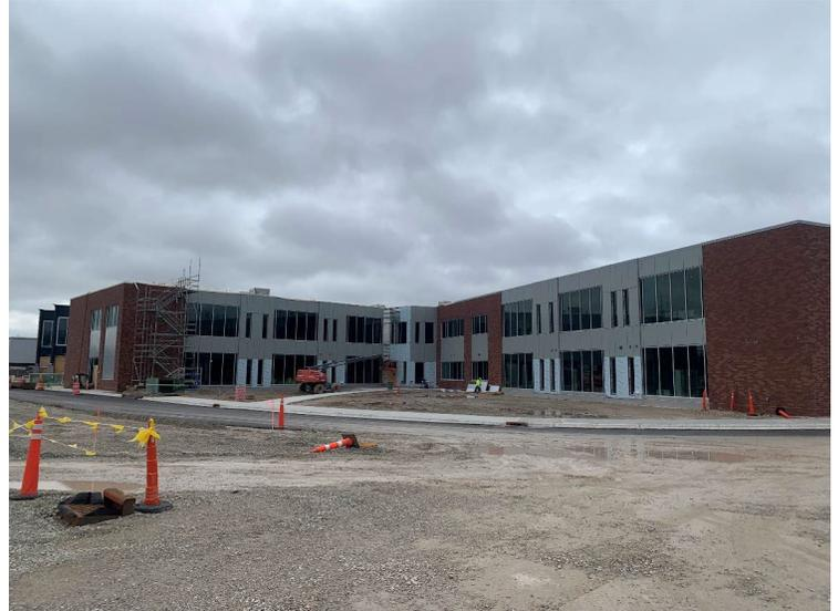
Se está a punto de finalizar la instalación de los paneles de pared compuesto y se están empezando a colocar los dispositivos eléctricos exteriores.
